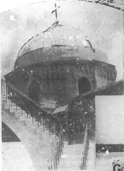
La cúpula de la Iglesia del Santo Sepulcro, en la que pueden apreciarse, a simple vista, las grietas producidas por el terremoto que recientemente asoló el territorio donde está situada esa famosa iglesia.
